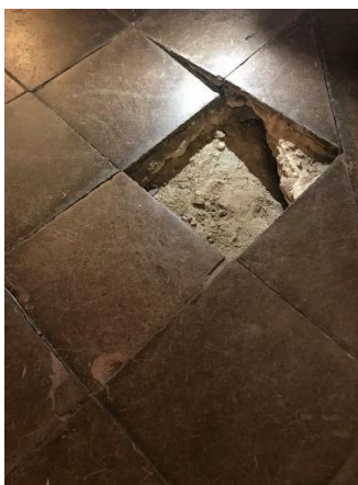
Defekter Fußboden
